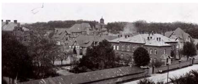
Das Gelände der Provinzial-Blindenanstalt mit dem Vorschulhaus, dem Mädchenhaus, dem Wirtschaftsgebäude und dem Knabenhaus [4]
